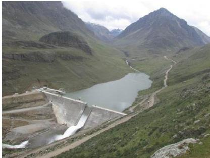
La central hidroeléctrica cuenta con una presa de almacenamiento de agua (presa de Pallca); un túnel de 10 km de longitud; tubería forzada de 2.5 km; y una casa de máquinas superficial.
